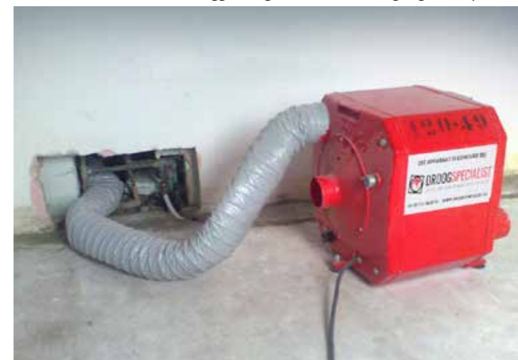
Vocht onder een bad wordt weggedroogd vanuit een naastgelegen slaapkamer.
