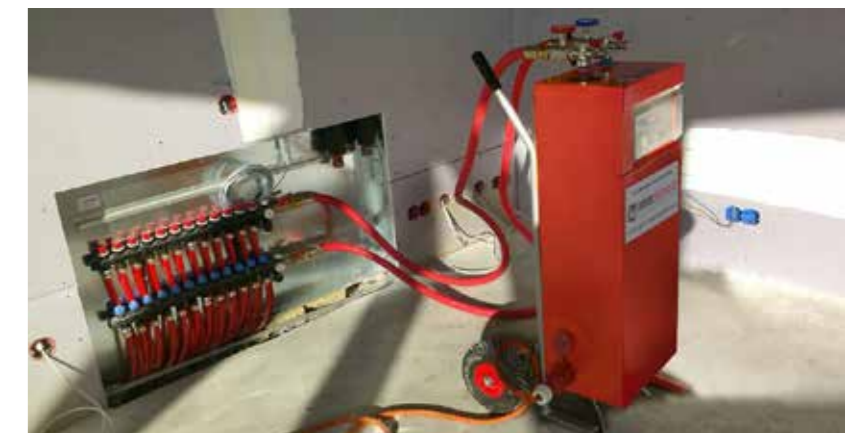
Warmwaterboiler aangesloten op de vloerverwarming.
