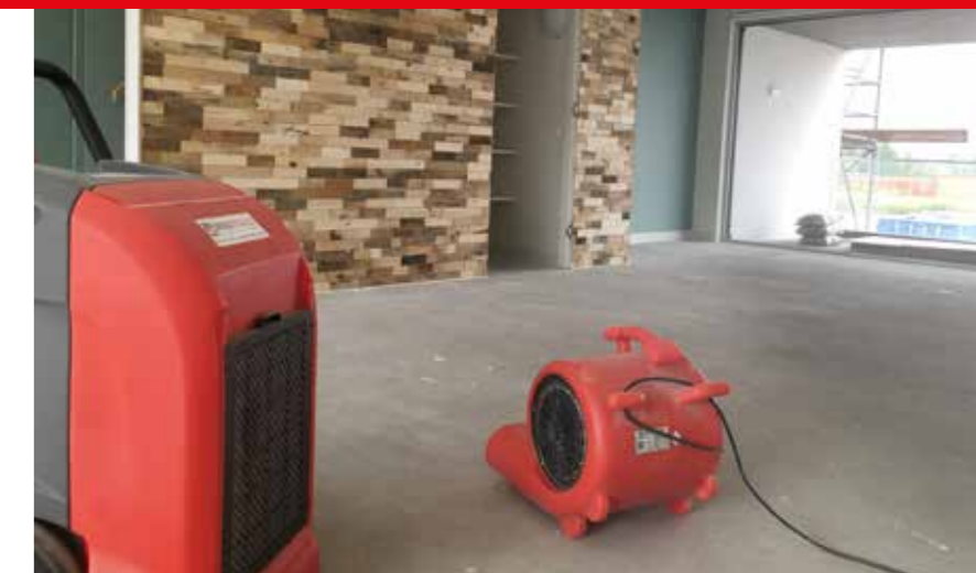
Droging van vloer ten behoeve van vloerafwerking.
