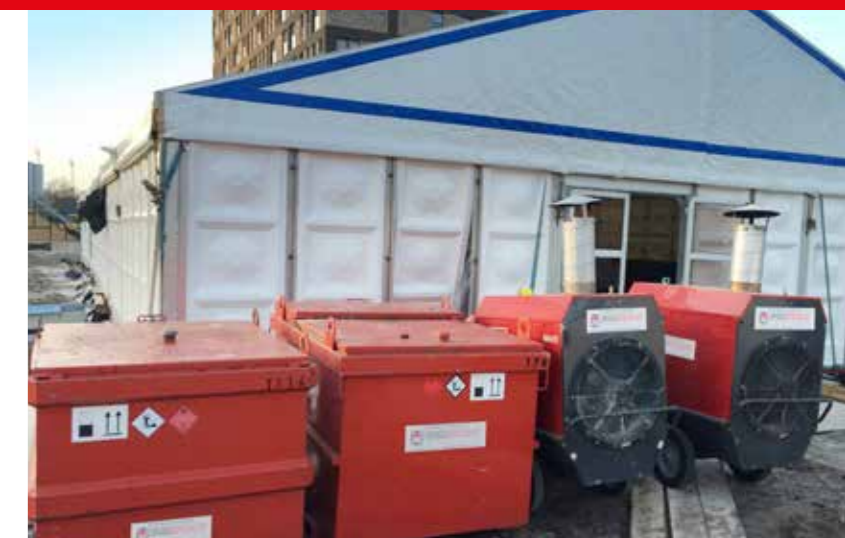
Tent wordt verwarmt zodat werkzaamheden kunnen doorgaan in de winterperiode.
