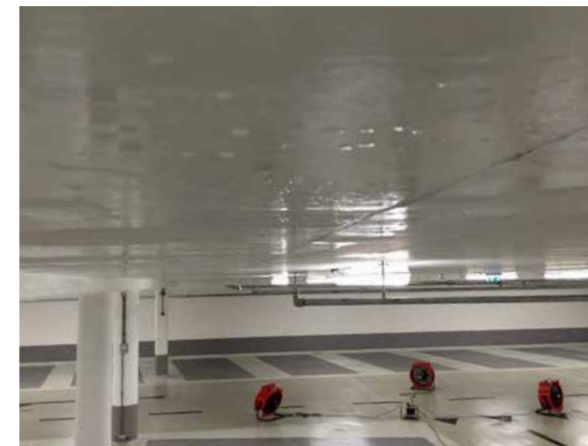
Ventilatoren zorgen voor een goede verspreiding van de droge lucht.
