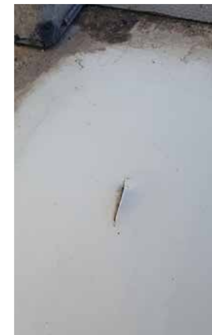
Beschadigde dakbedekking.
